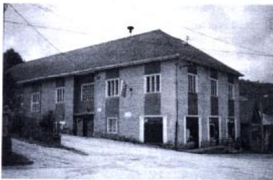
Viacúčelová budova (Obecný úrad, kultúrny dom, obchod – rozličný tovar)
