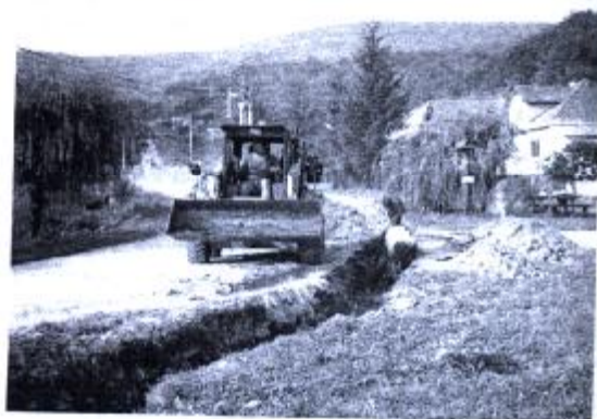
Výkopové práce pri zakladaní plynového potrubia.
